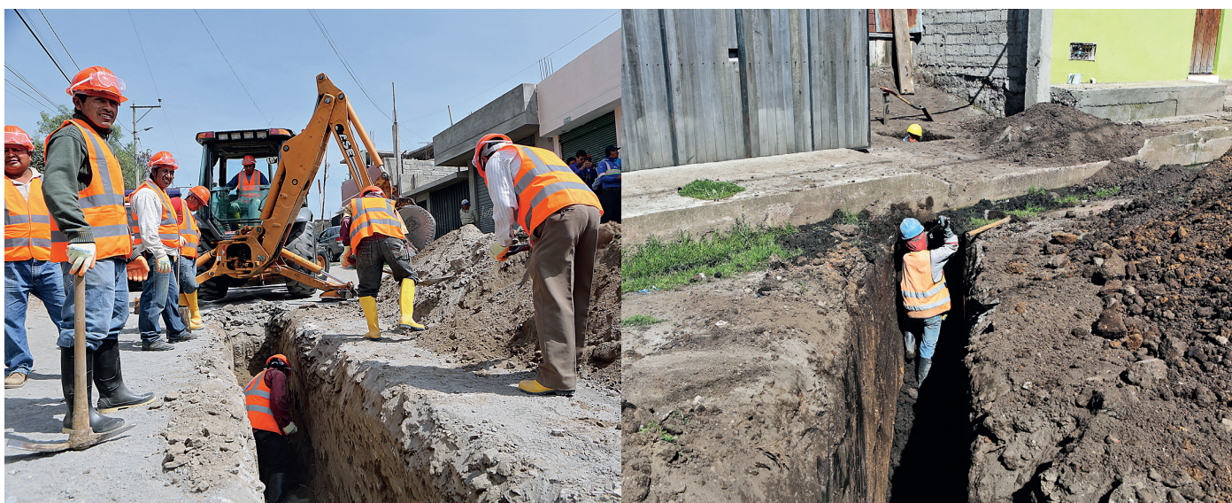
Fotos: Obras de alcantarillado que se realizan en toda la ciudad
