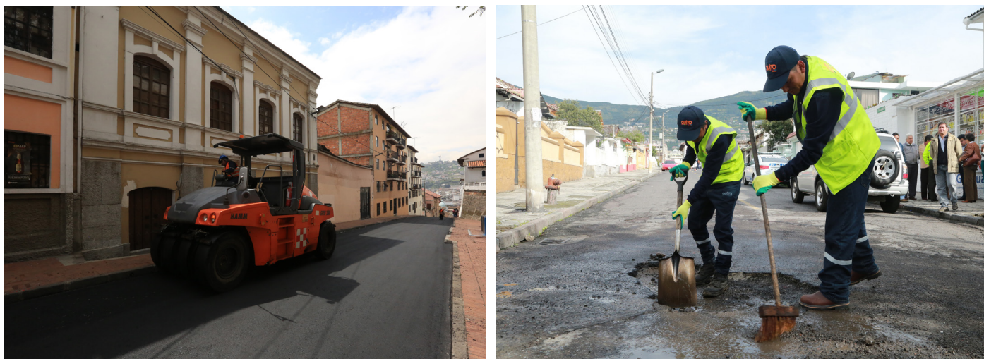
Foto: Programa de Rehabilitación y Mantenimiento Vial
